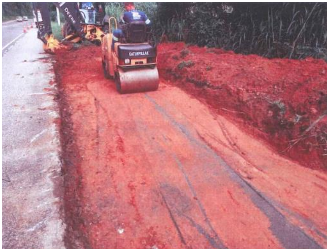
Figura 6.326.12 Rota 116 – Implantação de Refúgio– Km 99+000 Sul [1]
