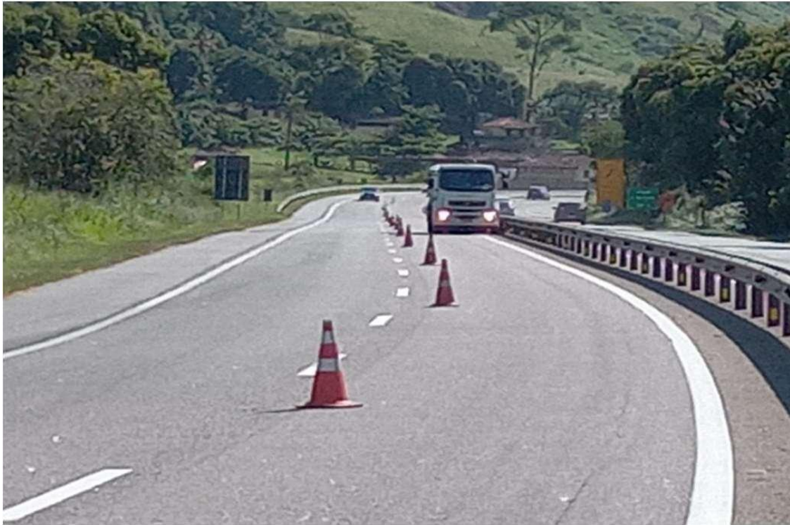
Figura 6.17 Via Lagos – Varrição Mecânica de Mediana - Km 18+000 Norte
