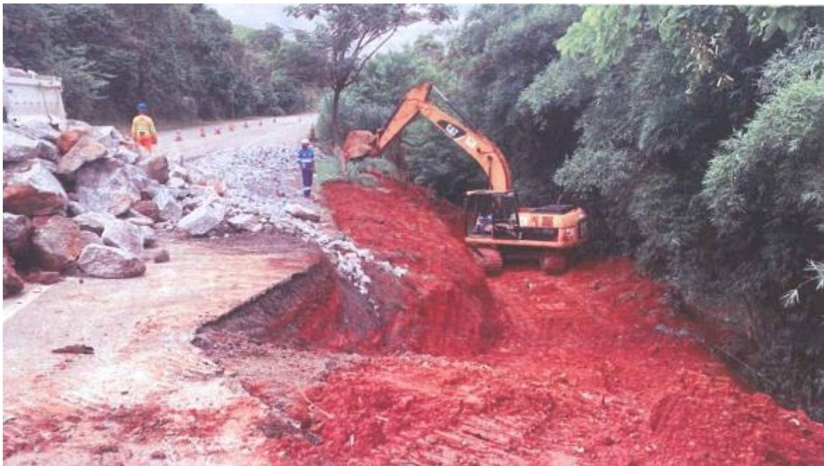
Figura 6.386.18 Rota 116 - Reestruturação do Pavimento – Km 129+000 Norte
