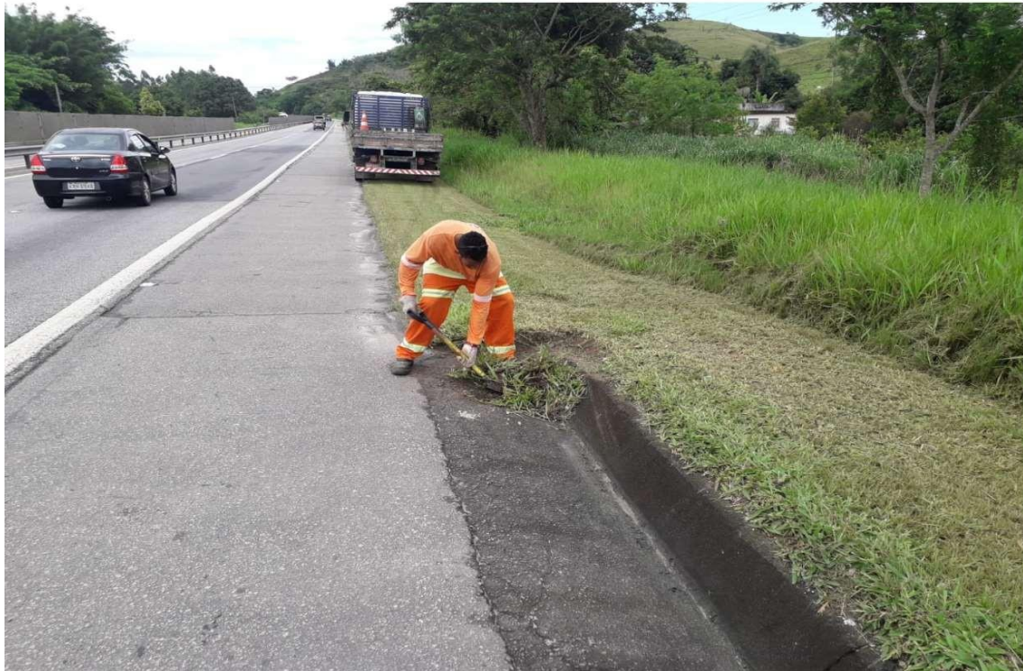
Figura 6.7 Via Lagos – Limpeza de Sarjeta – Km 16+000 Sul
