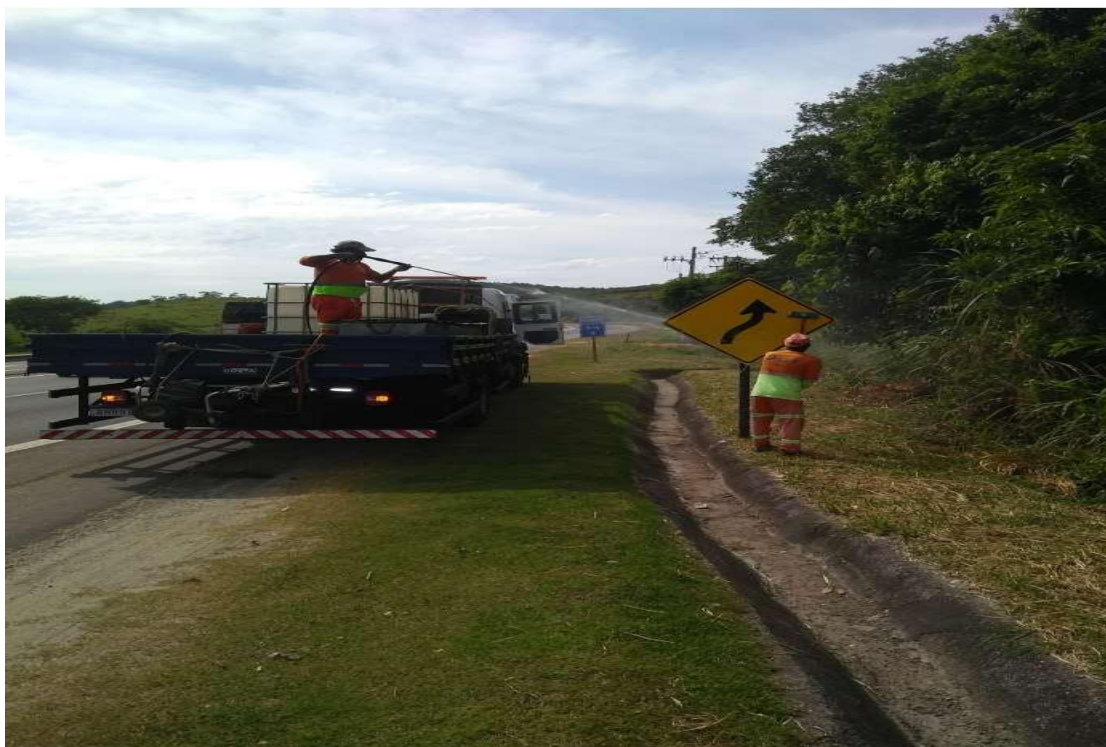
Figura 6.2 Via Lagos – Limpeza de Placa – Km 4+000 Norte
