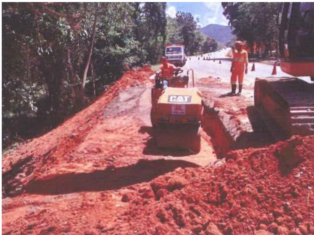
Figura 6.236.3 Rota 116 – Restauração da Drenagem – Km 14+000 Sul [1]
