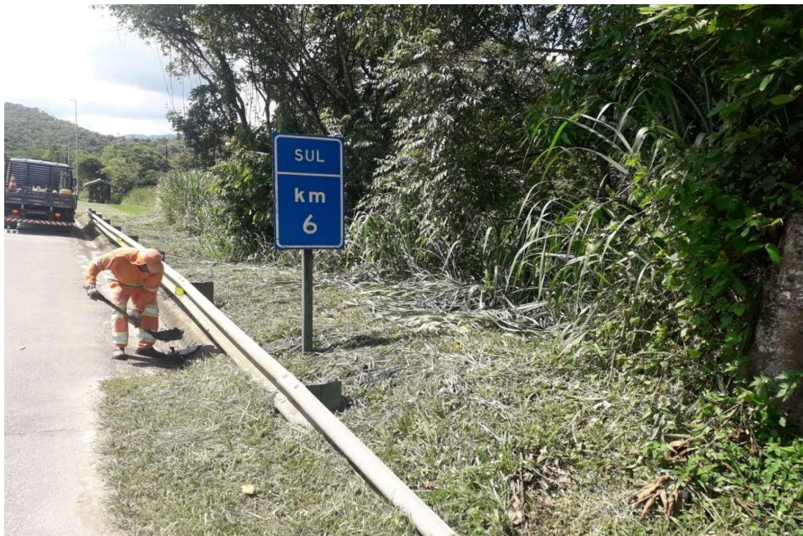
Figura 6.6 Via Lagos – Limpeza de Sarjeta – Km 6+000 Sul
