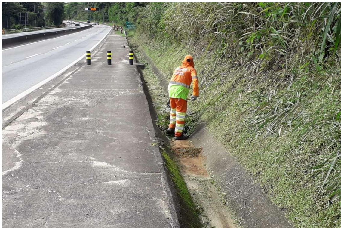
Figura 6.8 Via Lagos – Limpeza de Valeta de Corte – Km 1+300 Norte
