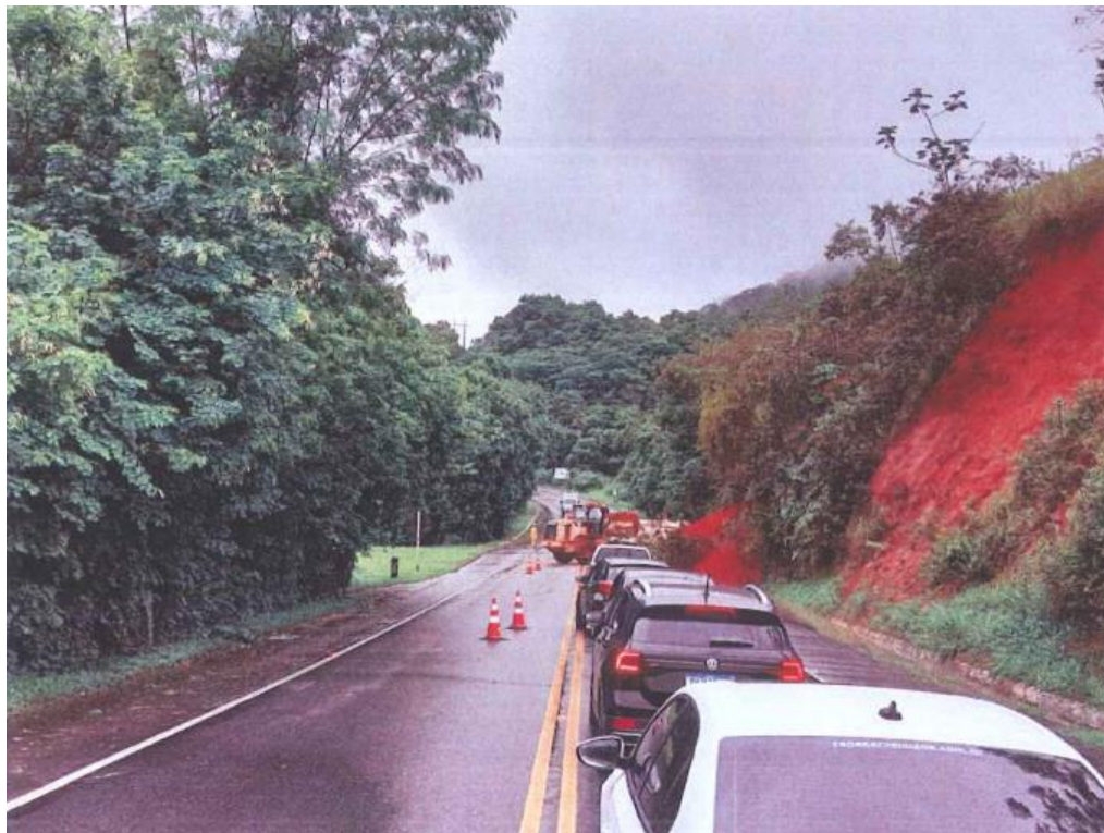
Figura 6.256.5 Rota 116 – Queda de Barreira – Km 34+700 Norte [1]
