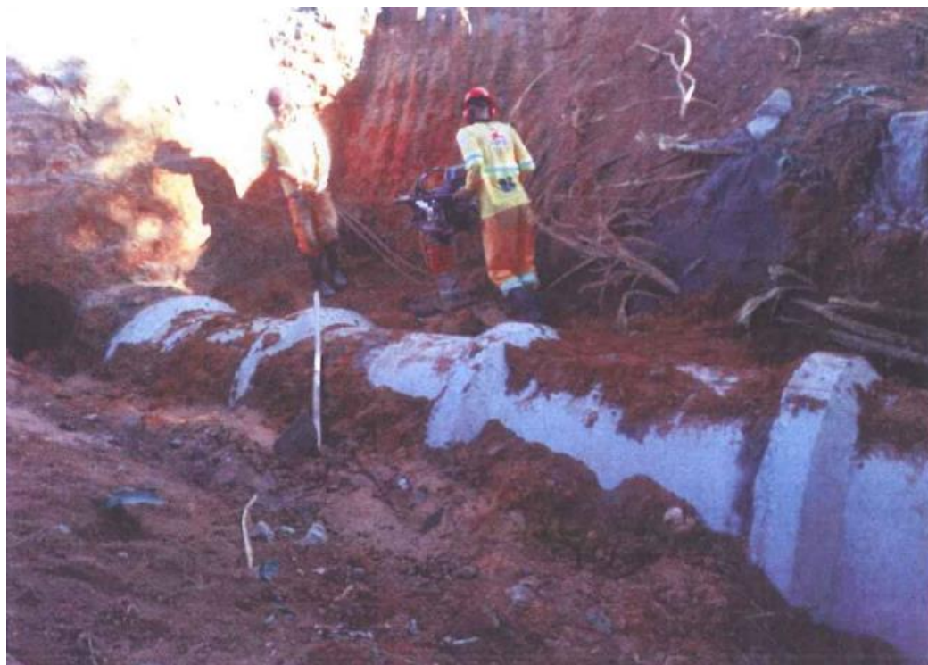
Figura 6.246.4 Rota 116 – Restauração da Drenagem – Km 14+000 Sul [2]
