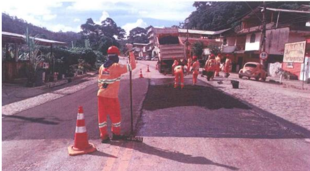
Figura 6.346.14 Rota 116 – Reparos no Pavimento – Km 115+500
