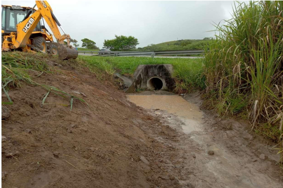
Figura 6.9 Via Lagos – Limpeza de Bueiro – Km 44+000 Norte
