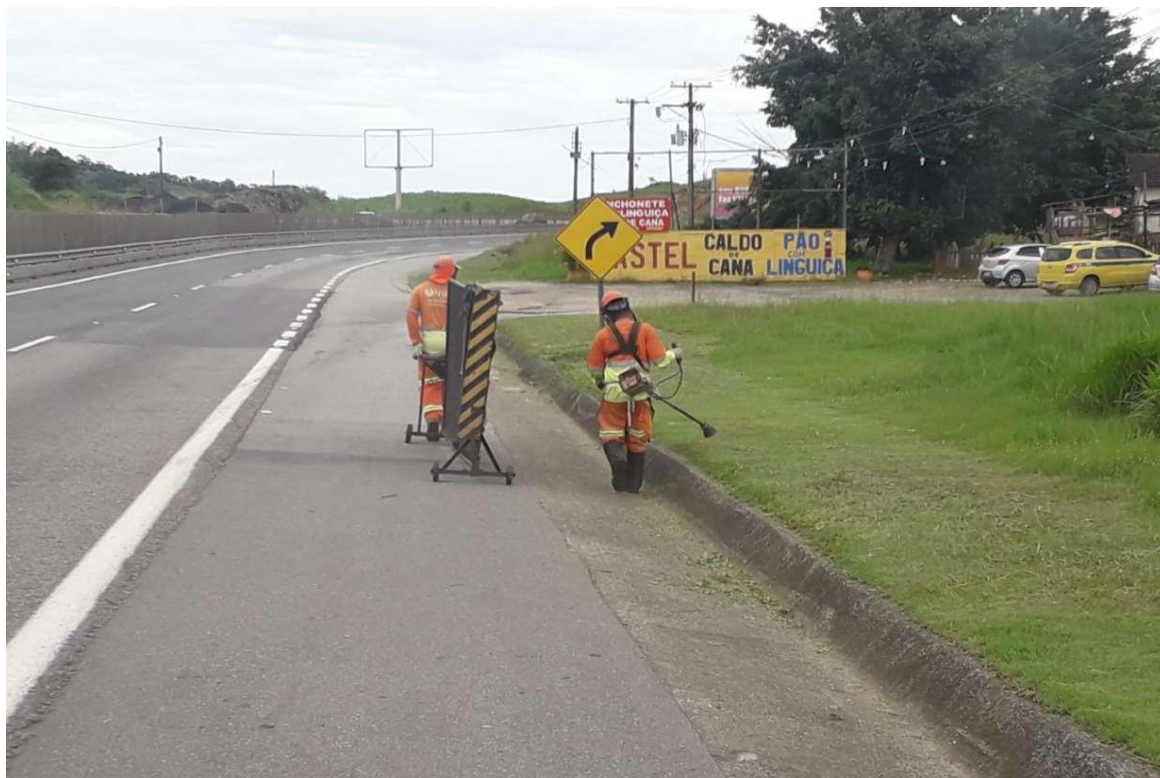
Figura 6.13 Via Lagos – Roçada Manual - Km 8+200 Norte
