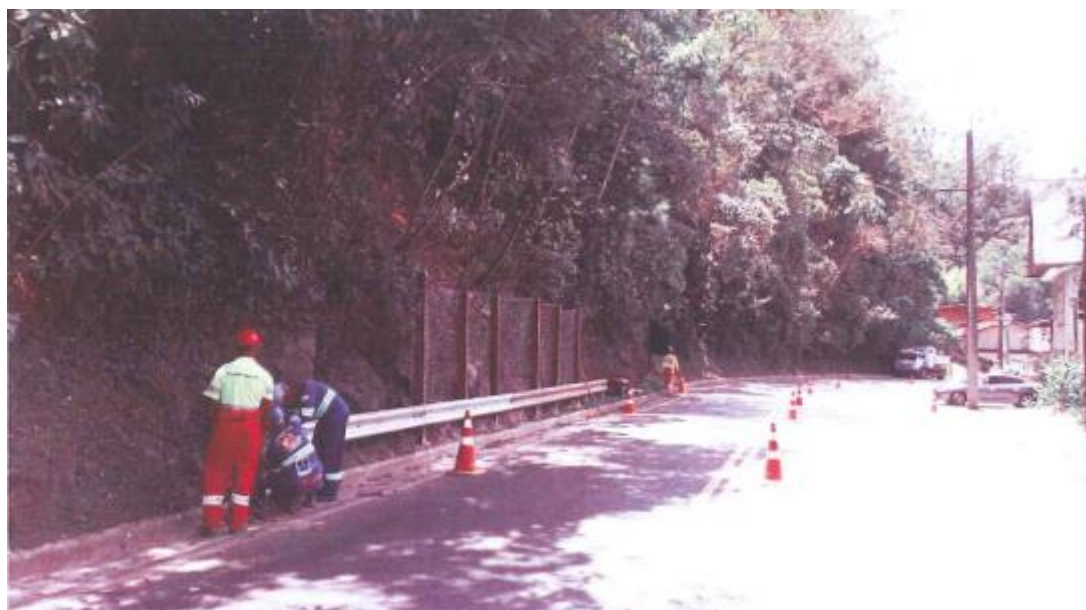
Figura 6.306.10 Rota 116 – Implantação de Dispositivo de Segurança – Km 73+300
