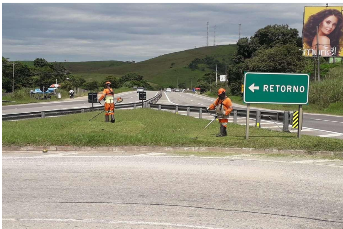
Figura 6.14 Via Lagos – Roçada Manual - Km 14+460 Norte
