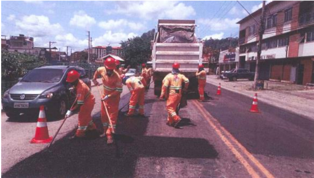
Figura 6.316.11 Rota 116 – Reparos no Pavimento – Km 84+000
