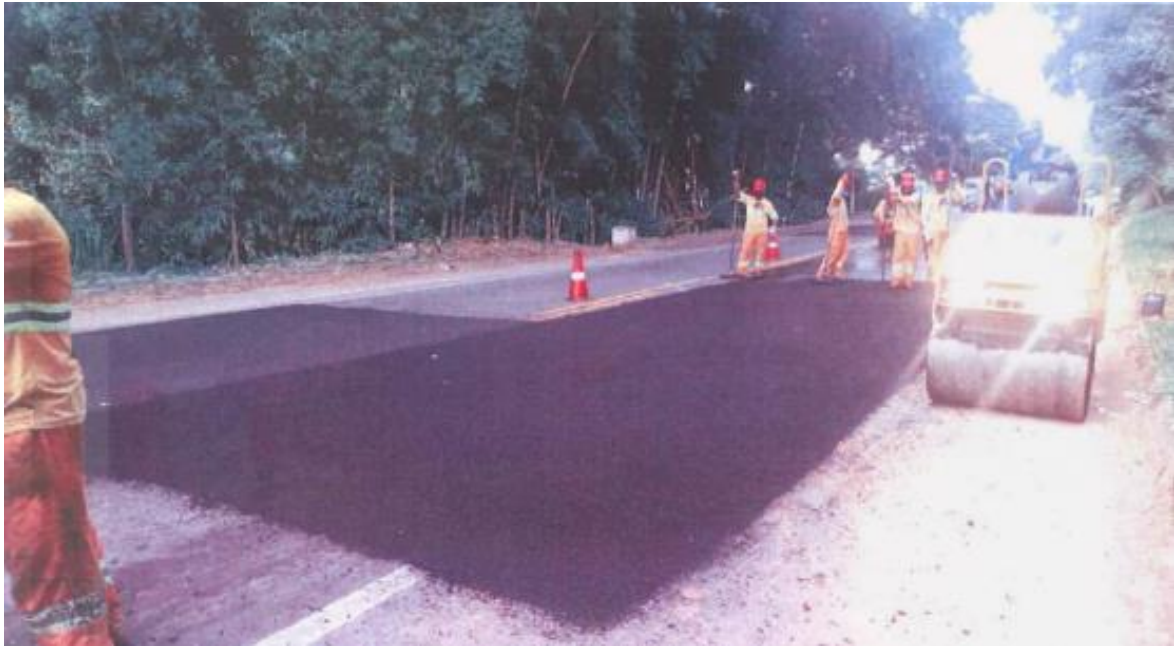
Figura 6.376.17 Rota 116 – Reparos no Pavimento – Km 128+200
