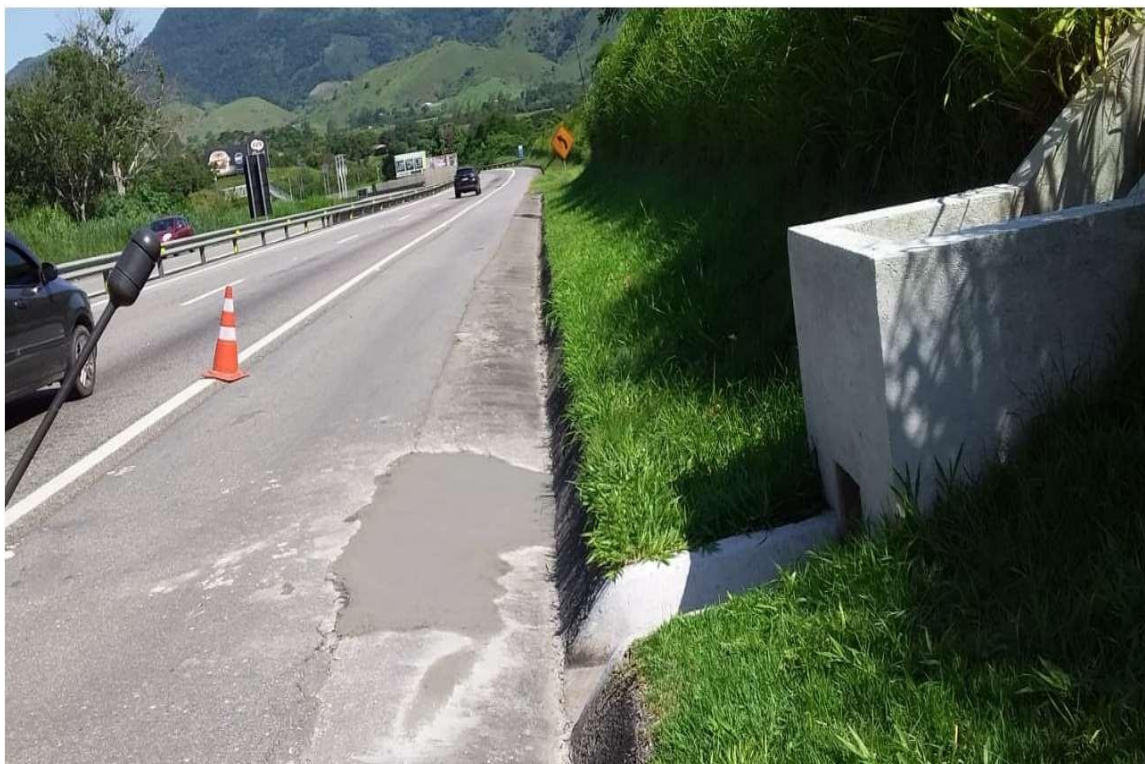
Figura 6.12 Via Lagos – Reparo na Sarjeta – Km 9+800 Norte [2]6.2
