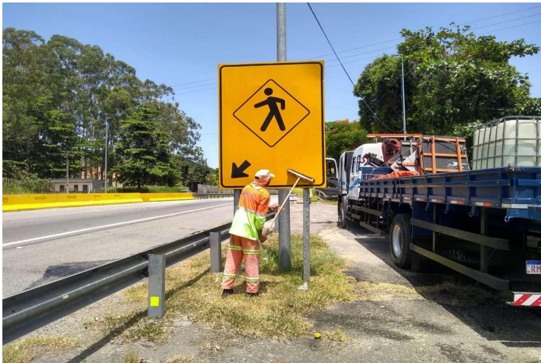
Figura 6.3 Via Lagos – Limpeza de Placa – Km 21+240 Sul
