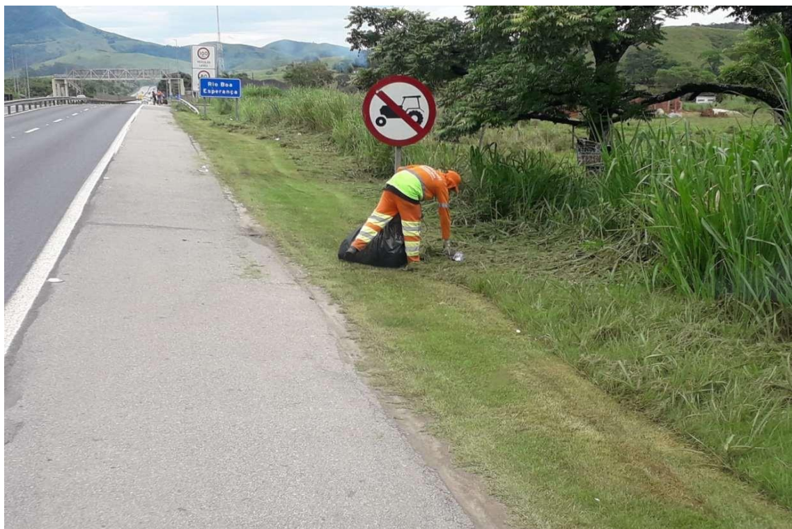
Figura 6.22 Via Lagos – Cata Cata - Km 12+600 Sul
