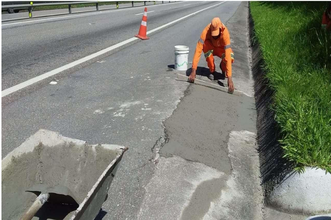
Figura 6.11 Via Lagos – Reparo na Sarjeta – Km 9+800 Norte [1]
