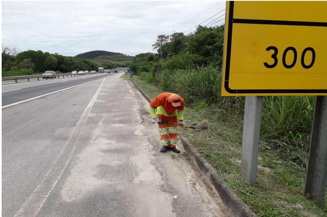
Figura 6.5 Via Lagos – Limpeza de Sarjeta – Km 3+800 Norte
